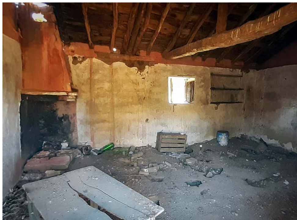
Interior de una de las casillas en su estado actual
